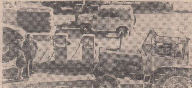
Казахская ССР. Автоматизированная база горюче-смазочных материалов вступила в строй в целинном совхозе «Путь Ильича» Павлодарской области. Она даст значительную экономию нефтепродуктов, которые раньше терялись при ручной заправке. Склад моторных масел размещен под землей.
